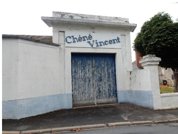
LE PORCHE PERMETTANT L'ACCES A L'ANCIENNE USINE
