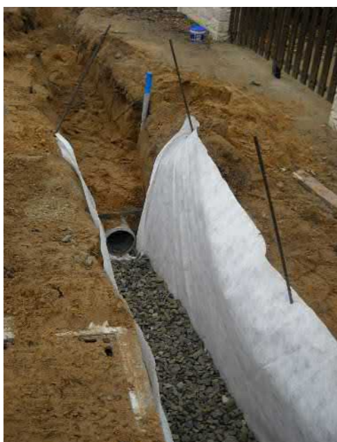
Ill.3 : exemple d'une réalisation d'une tranchée drainante
