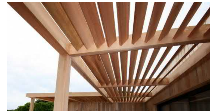
Débords de toit métallique ou bois
