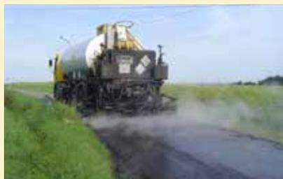
Enduit superficiel d'usure
