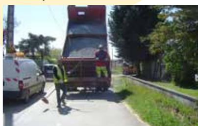
Reprofilage PATA (Point à temps automatique)
