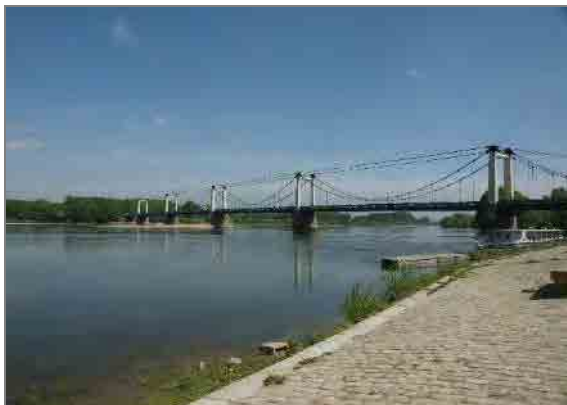
Les quais de Montjean-sur-Loire
