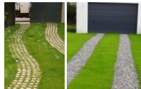
Bandes roulerantes avec revêtements porteurs et bandes enherbées
