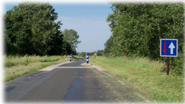
Les chicanes réduisent la vitesse des véhicules, mais elles doivent être dimensionnées pour permettre le passage des engins agricoles.
