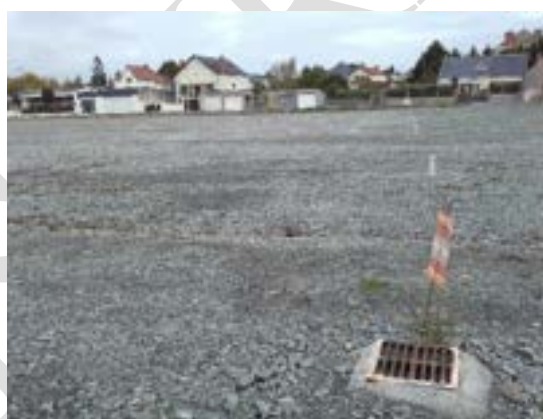
Piquet de signalisation et regard indiquant la localisation de la rivière busée
