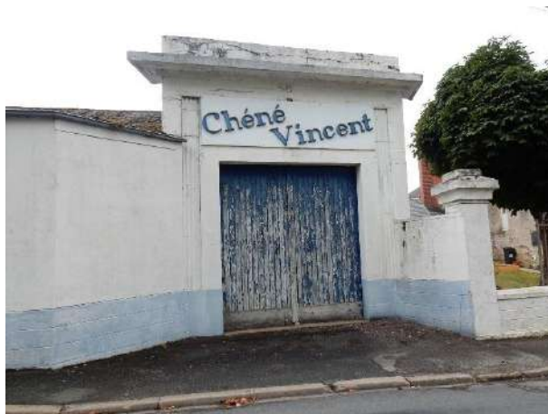
LE PORCHE PERMETTANT L'ACCES A L'ANCIENNE USINE
