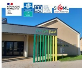
Restructuration de l'école Beausse
