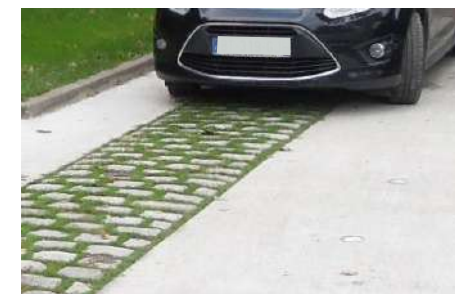
Bandes de roulement en béton avec pavés engazonnés au centre
