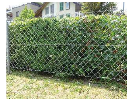
Grillage surélevé de 5 à 8cm
