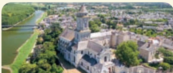
SAINT-FLORENT-LE-VIEIL RÉHABILITATION DE L'ÉGLISE ABBATIALE
